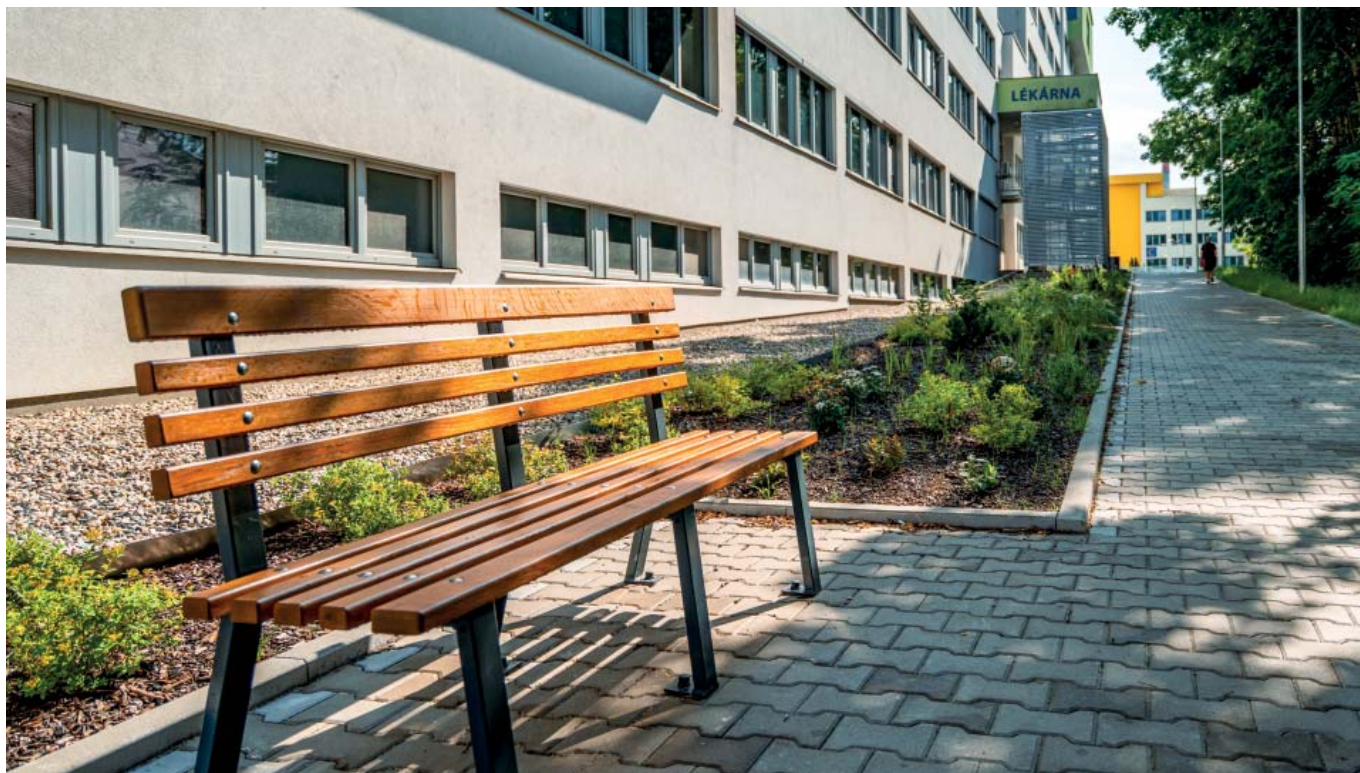
Modernizace přístupu do Polikliniky, část III. – nový přístup do Polikliniky
